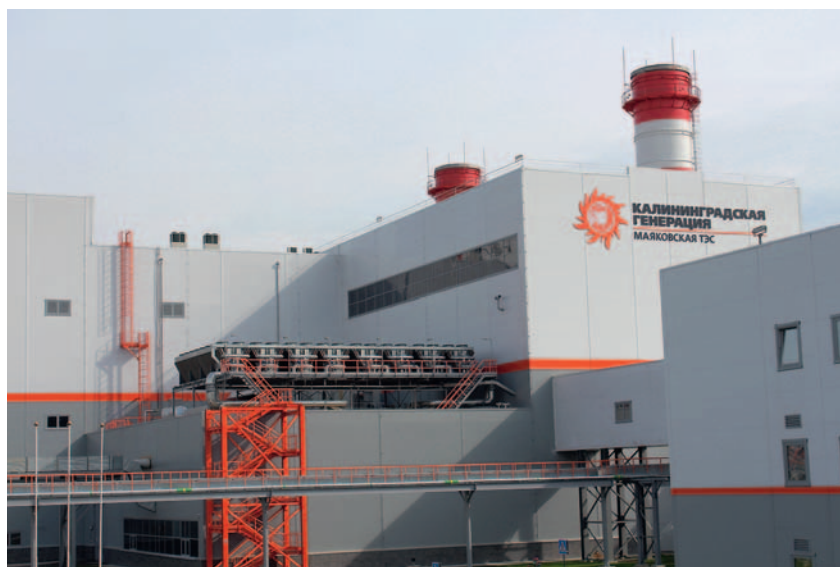
Маяковская ТЭС в Калининградской области
